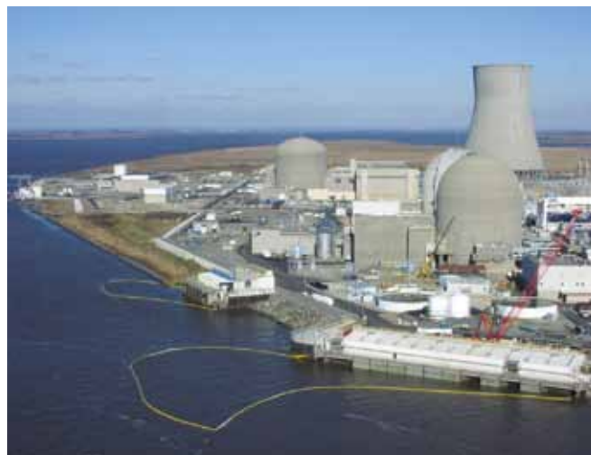
▲ 图 7：应该保护进水口，以防止油类影响热交换装置，此类装置很难清理，可能会导致设施关闭。
