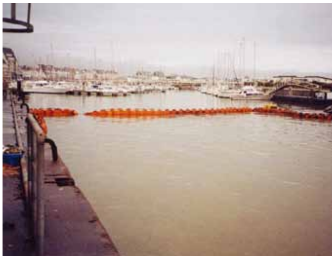
▲ 图 2：如果栅栏被进出的船只破坏，码头部部署栅栏的成效可能会大打折扣。
